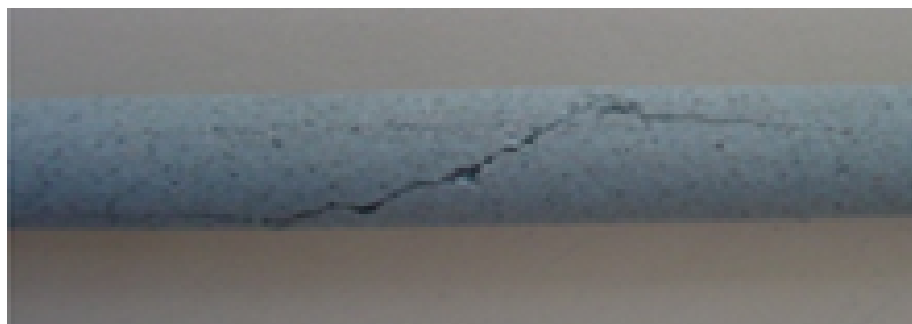
Figura 2.19 - Trincas longitudinais. Fonte: SENAI, 2011.
