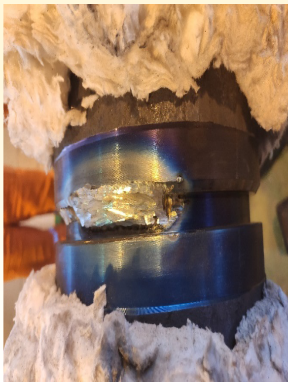
Figura 7.33 – Retirada das escamas com esmerilhadeira. Fonte: OS AUTORES.
