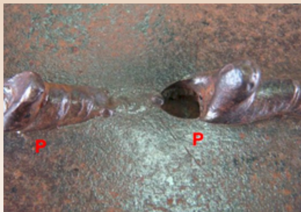
Figura 1.36 – Perfuração na Raiz. Fonte: AWS VIW-M, 2008, p. 2-2 a 2-4.
