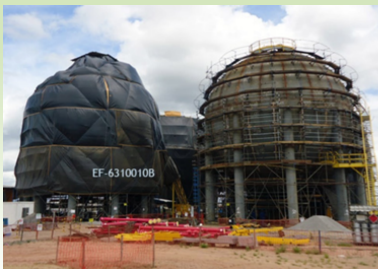
Figura 5.70 – Isolamento Externo. Fonte: Portal Petrobras, ENG-AB/IECOMPERJ/IEOFF, Notícia: IEUC dá início aos preparativos para tratamento térmico de alívio de tensões das esferas do Comperj
