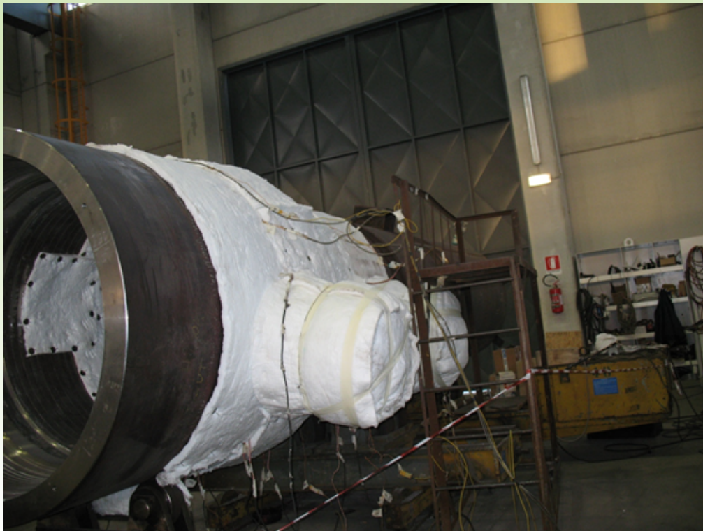
Figura 5.71 – Tratamento térmico localizado de permutadores Breach Lock . Fonte: os autores, 2015.
