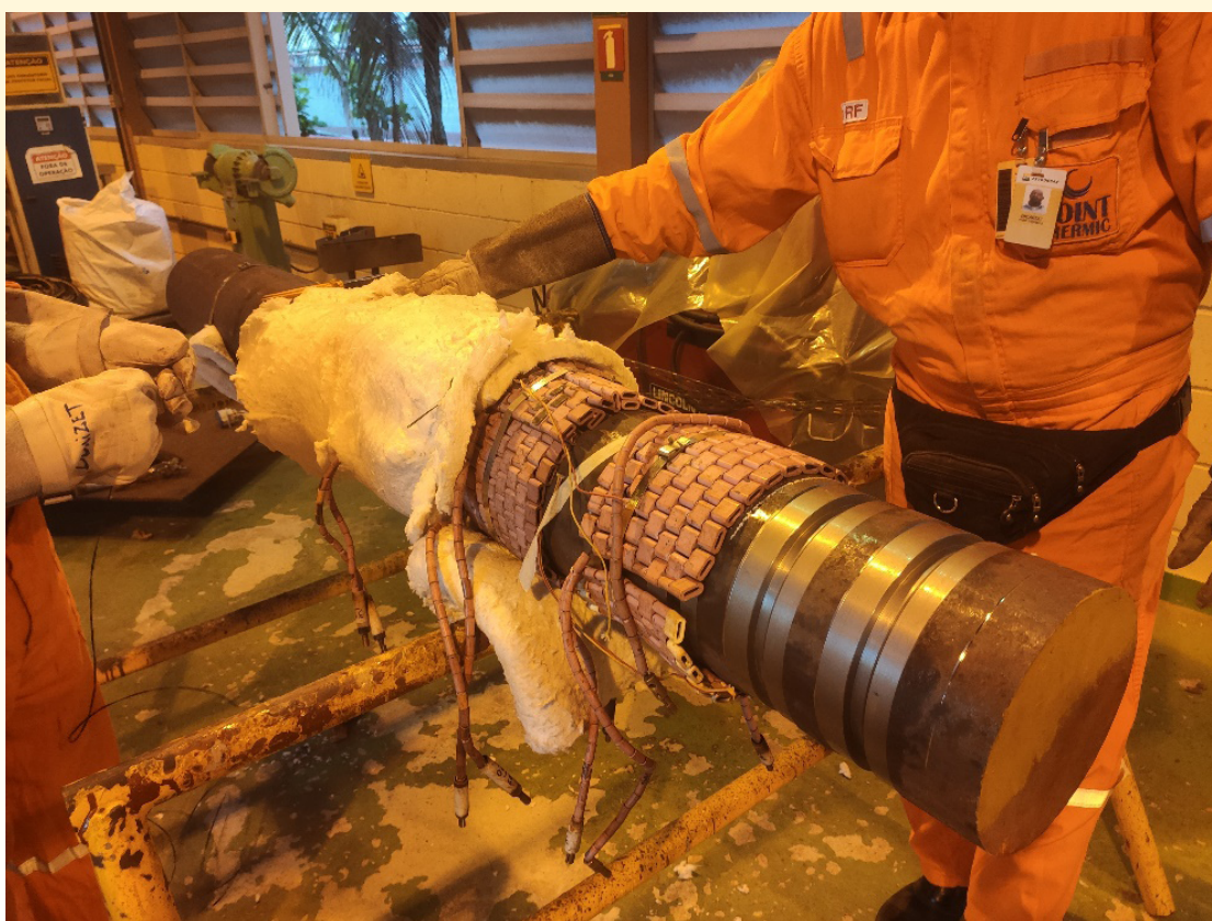
Figura 7.26 – Montagem do sistema de resistência. Fonte: OS AUTORES.
