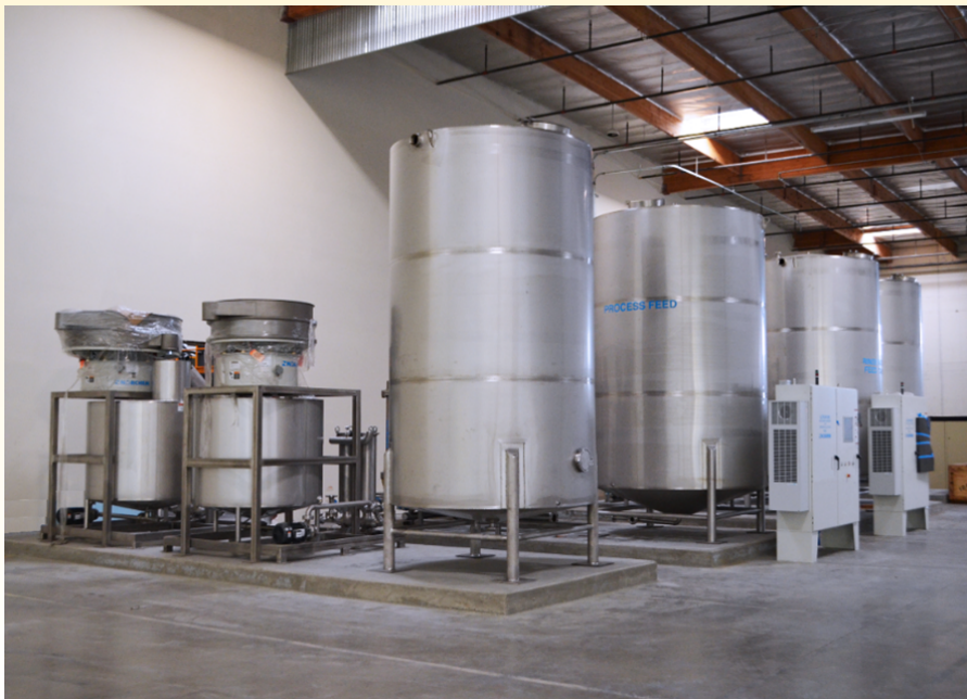
Figura 8.30 – Imagem dos tanques soldados
