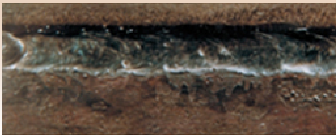
Figura 1.30 – Juntas soldada com deposição incompleta. Fonte: AWS VIW-M, 2008, p. 2-2 a 2-4.
