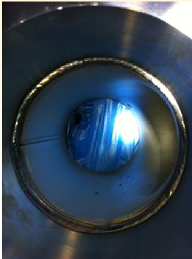
Figura 8.36 – Aspecto da raiz dos tanques
