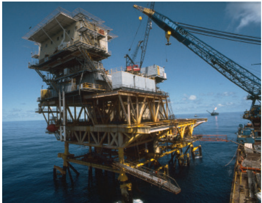
Montagem da plataforma de Garoupa, Campos, RJ
