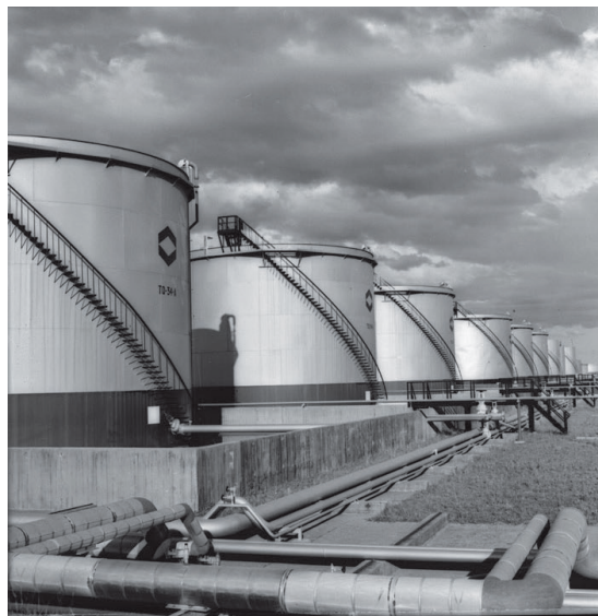
Tanques da Refinaria Alberto Pasqualini (REFAP), Canoas- RS, 1976
