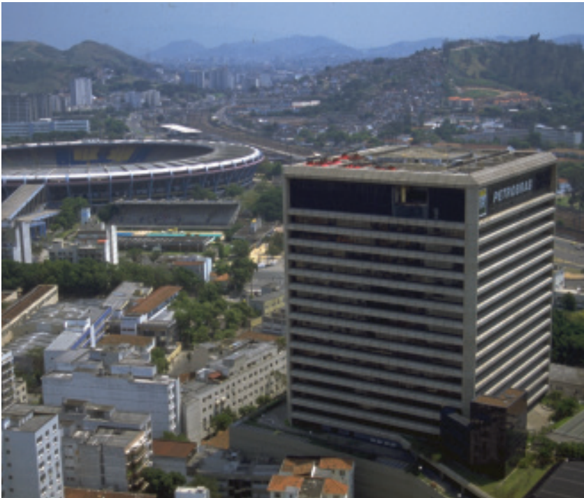
Edifício Horta Barbosa, EDIHB
