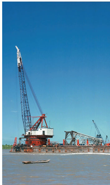
Lançamento da jaqueta da plataforma fixa de Guaricema na bacia Sergipe-Alagoas, Aracaju, SE
