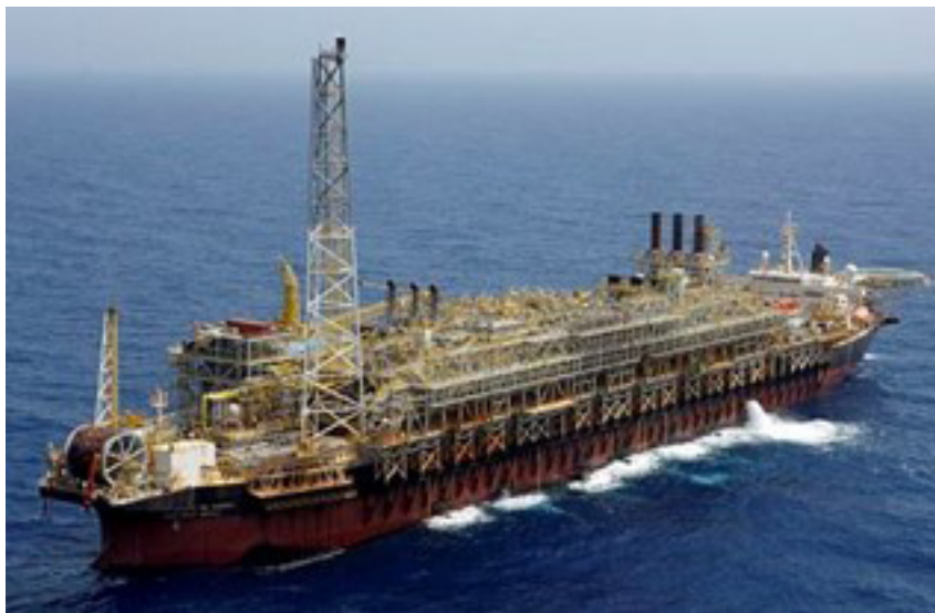
Figura 4.1. FPSO Cidade de Angra dos Reis, destacando a complexidade da planta de processamento embarcada em uma Unidade de Produção típica do Pré-sal.
