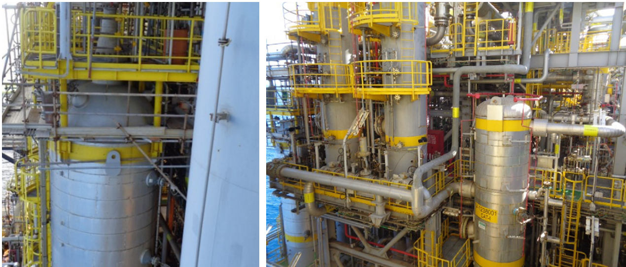
Figura 4.3 Unidade de desidratação de gás com peneiras moleculares.
