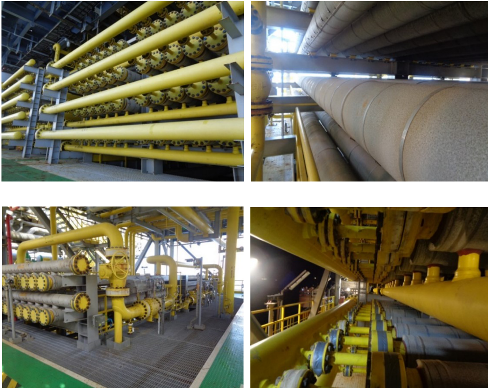
Figura 4.2. Módulo de separação de CO 2 por membranas.
